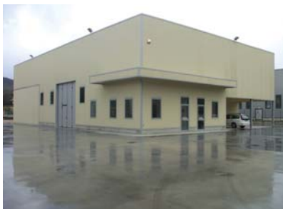
Deposito dell'Impresa in Montorio al Vomano (TE).
