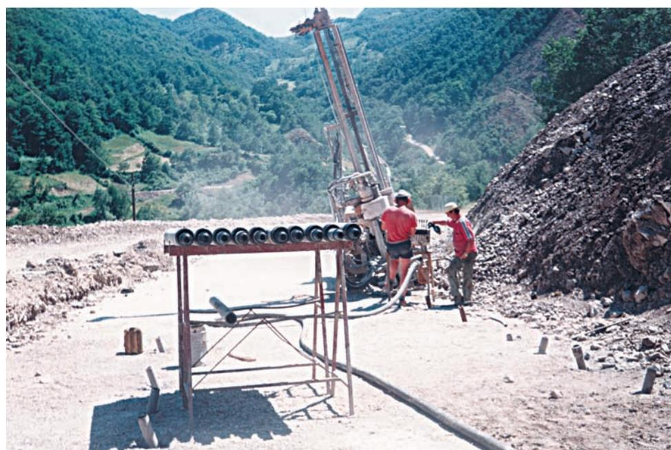
*Nella sequenza di immagini, la esecuzione di micropali a sostegno di una platea in cemento armato e il muro di contenimento del terreno collegato allo stesso mediante tiranti in trefoli d'acciaio.*
