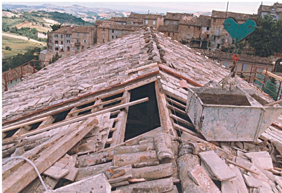
dei coppi con integrazione degli elementi mancanti. Sono stati effettuati la pulizia, il trattamento antitarpe ed il trattamento ignifugo della orditura lignea della copertura ed infine sono stati posti nuovi pluviali e grondaie in rame. Per la realizzazione dell'impianto termico per i locali del teatro è stato previsto un impianto del tipo ad acqua calda con circolazione forzata, frazionato in circuiti indipendenti per zone omogenee da riscaldare.
