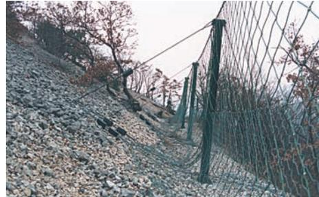
*Nelle immagini, i vari interventi effettuati: consolidamenti con micropali, posa di barriere e reti paramassi, consolidamento del versante costituito da materiale incoerente con acclività a rischio situato a monte dell'abitato.*
